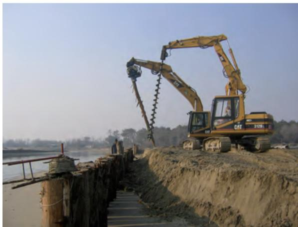
Figura 8 - La realizzazione della palificata in legno nella zona della nuova foce.
