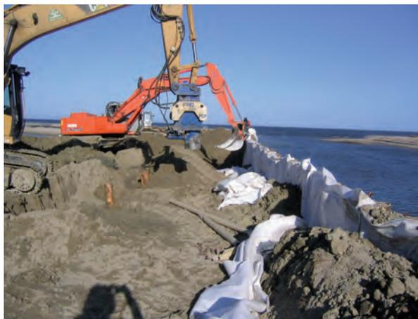
Figura 9 - La posa in opera del geotessile a tergo della palificata in legno nella zona della nuova foce.
