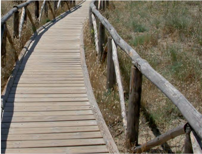
Figura 10 - Modello di passerelle in legno, con o senza staccionate, previsto per l'area di Sterpaia (tipologie utilizzata nell'ambito del Parco Regionale di Migliarino, San Rossore e Massaciuccoli).
