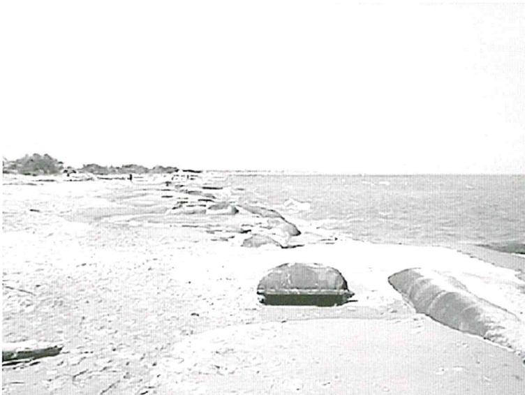
**Figura 5 - Un tentativo di protezione della costa mediante sacconi e tubi Longard.**
