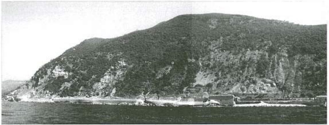
Figura 10 - Litorale Punta Rospo - Deiva Marina: le opere di presidio della ferrovia del litorale ligure mostrano lesioni legate all'erosione da parte dei mari di libeccio e di scirocco. L'attività delle frane in roccia del versante sovrastante ha subito un rallentamento in seguito alla costruzione di dette opere, ma l'apporto solido che arriva al mare, salvo rare eccezioni (a sinistra), è praticamente nullo.
