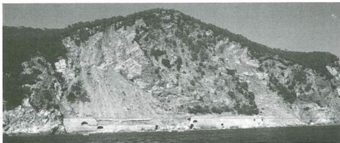
Figura 12 - Gli Apicchi: frane recenti del tipo crollo - valanga di detrito si sovrappongono alle rotture originarie, riconducibili a scivolamenti rotazionali regressivi. Le vecchie opere di presidio della ferrovia del litorale ligure svolgono un ruolo importante nell'evoluzione dei fenomeni franosi. L'interazione fra dinamica del versante, azione antropica ed erosione marina appare qui chiara.
