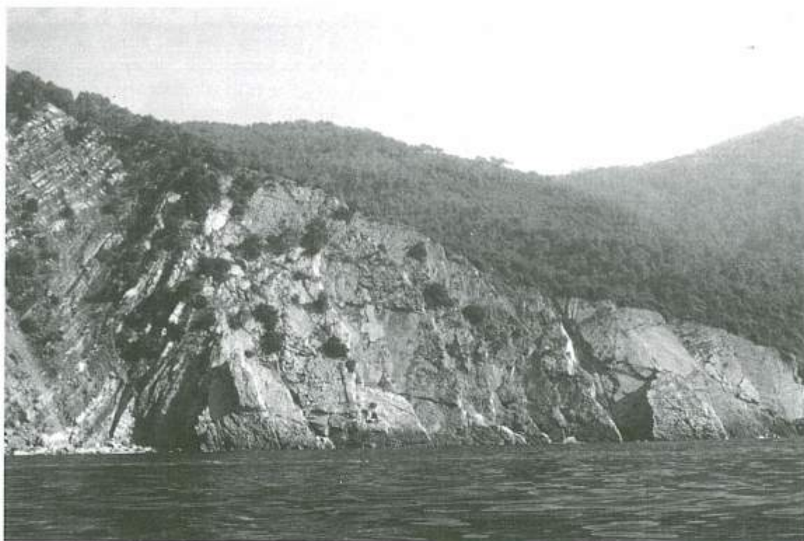
Figura 5 - Litorale di Punta Baffe (lato E): fenomeni misti di scivolamento traslazionale e crolli.
