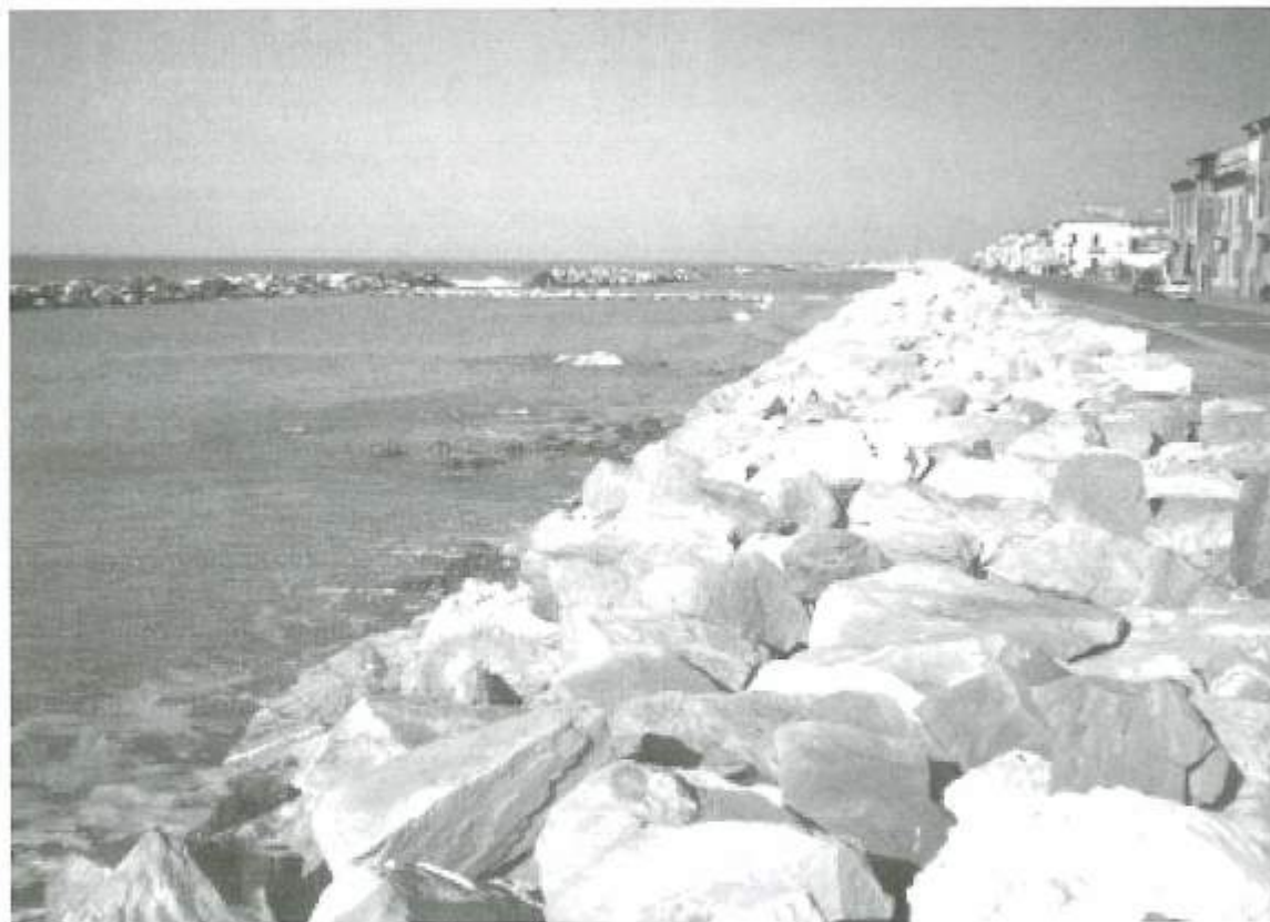
Figura 1b - Vista delle opere di difesa nel tratto centrale dell'abitato di Marina di Pisa.
