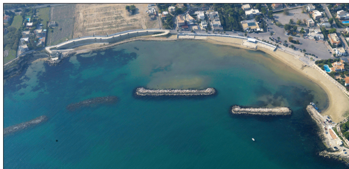
Figura 4 - Strada litoranea e muro di sostegno a Lido Colonna.
