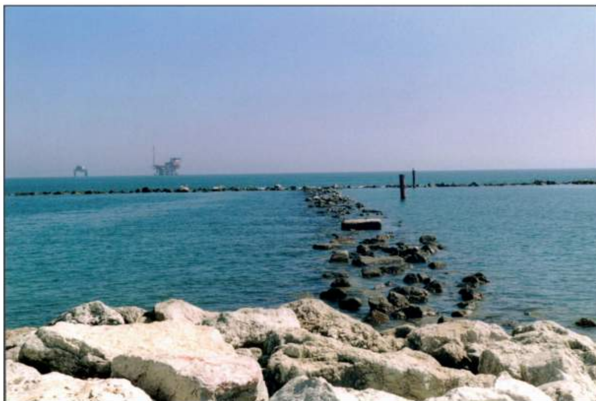
Figura 42 - Lido di Dante: setto trasversale di collegamento tra la scogliera semisommersa longitudinale e il pennello di ancoraggio alla spiaggia.
