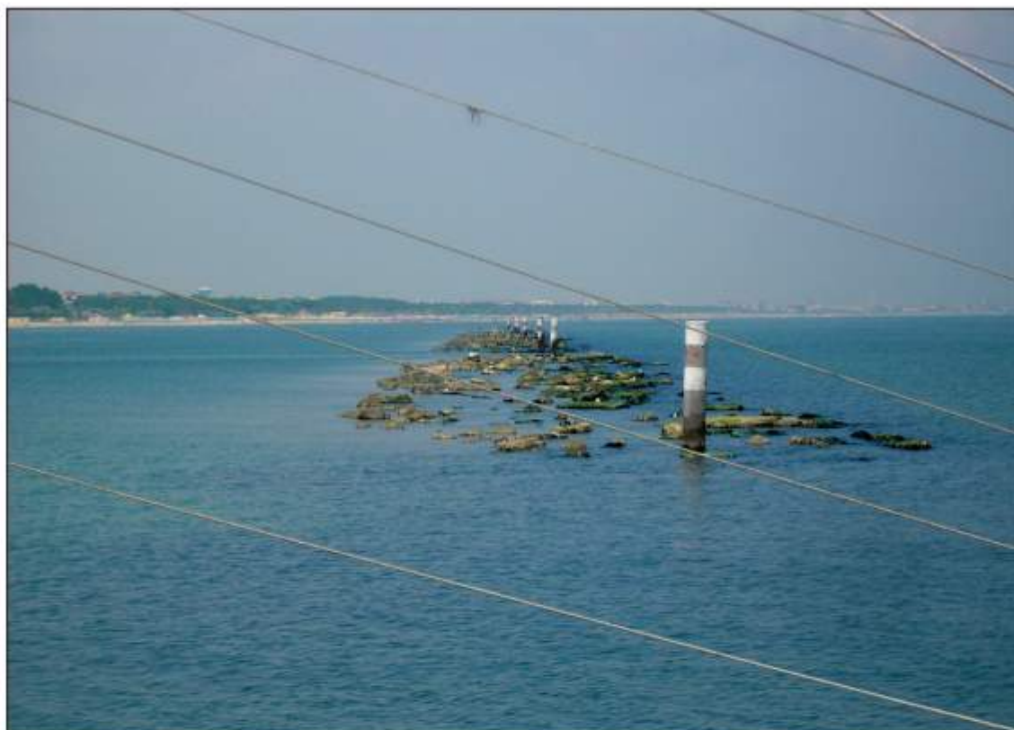
Figura 39 - Cesenatico Ponente: scogliera semisommersa. Lungo il litorale emiliano-romagnolo queste opere hanno la cresta alla quota del medio mare.
