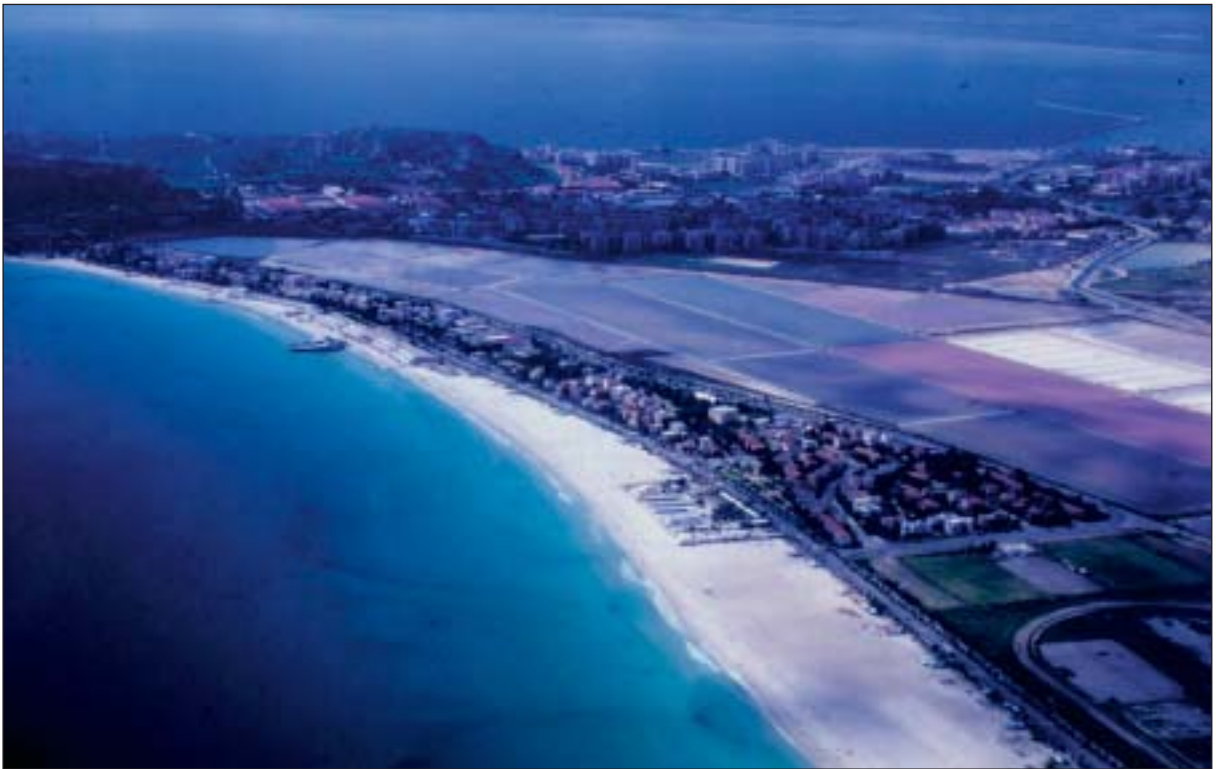
Il settore occidentale della spiaggia del Poetto di Cagliari che mostra l'area prima dell'intervento di ripascimento del litorale.
