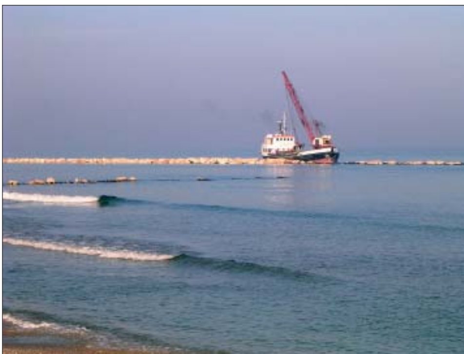
Messa in opera di sistemi di difesa costituiti da pennelli e barriere frangiflutto presso Martinsicuro.
