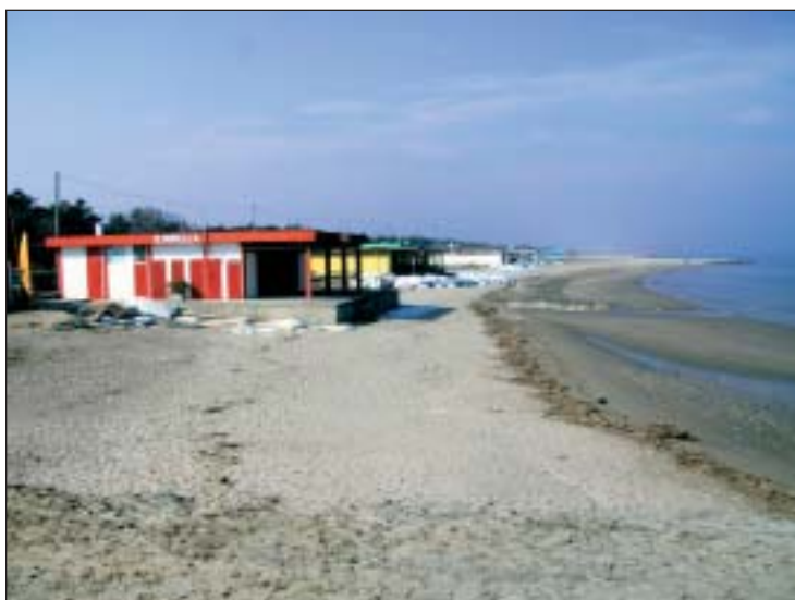
Difese in sacchi poste a protezione dei bagni a Punta Marina.
