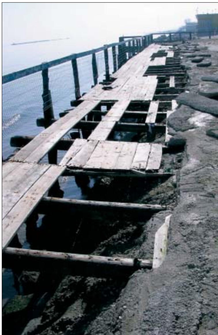
Opere aderenti a difesa delle strutture balneari e della viabilità cittadina di Martinsicuro.
