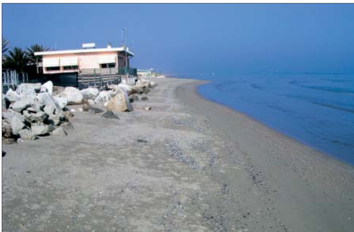
Tratto di litorale in erosione nel comune di Martinsicuro.
