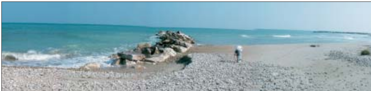
Fenomeni differenziati di erosione e di accumulo in corrispondenza di uno dei pennelli presenti lungo la spiaggia di Marinelle, a sud della foce del Trigno.
