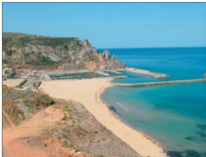
La spiaggia di Buggerru-Portixeddu (a sinistra) è battuta dai venti di maestrale e presentalocalizzati fenomeni di erosione che arrivano ad aggredire le dune retrostanti. I sedimenti in movimento verso sud vanno ad insabbiare il porto turistico di Buggerru (in alto), che rimane quindi inutilizzato.
