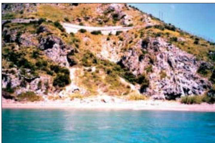
Cumulo di paleofrana al di sotto del tracciato stradale bordato da una spiaggia sabbioso-ciottolosa.
