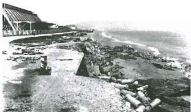
Figure 17a e 17b - Effetti dell'erosione costiera sulla spiaggia e sulla carreggiata della strada litoranea antistanti all'ex stabilimento Montecatini nel gennaio 1976.
