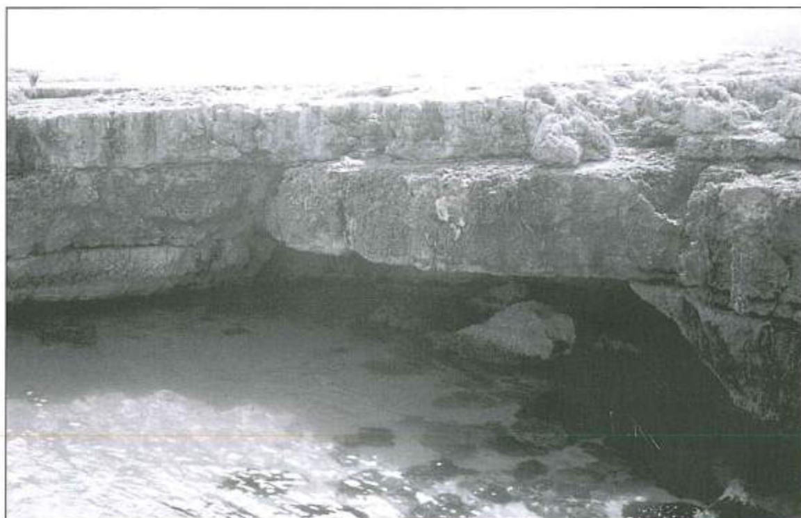
Figura 6 - Effetti della sollecitazione al piede della falesia: crollo e formazione di cavità e grotte (a Sud di Monopoli).
