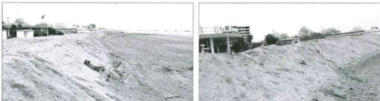
Figura 3 - Argini, alti circa 1.5 m e larghi 12 m, costruiti nell'inverno 2004, a difesa degli stabilimenti balneari del litorale del Lido delle Nazioni (FE), prelevando sabbia dalla spiaggia antistante.
