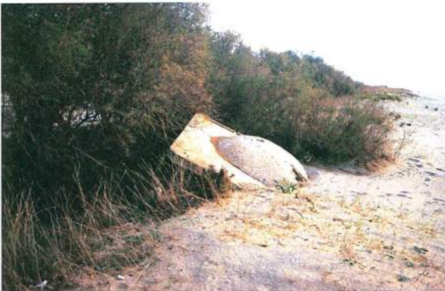
Figura 10 - La casamatta basculata sulla piccola duna della spiaggia di Torre Mozza (Febbraio 2003).
