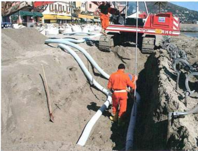
Figura 3 - Posizionamento dei tubi drenanti. Sulla destra si vedono i well points che consentono di tenere basso il livello della falda durante l'installazione.
