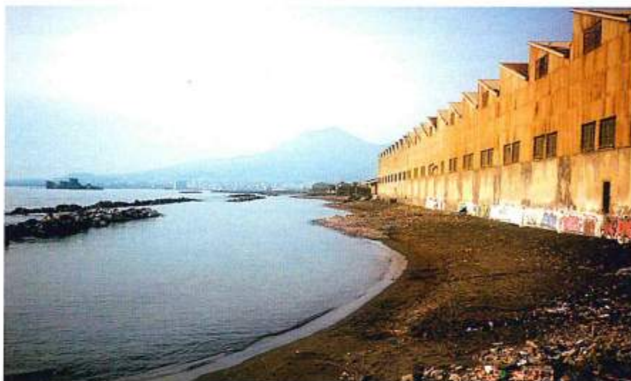
Figura 18 - Il tratto difeso dalle scogliere parallele (settore n. 6) sulla cui spiaggia sono presenti ingenti quantità di materiale di discarica.
