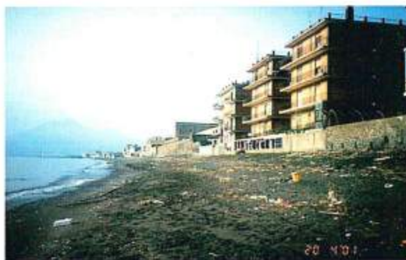
Figura 22 - La spiaggia del settore n. 3, che ha subito alterne fasi di erosione e progradazione e che, dopo la costruzione delle scogliere soffolte, mostra una tendenza all'avanzamento.
