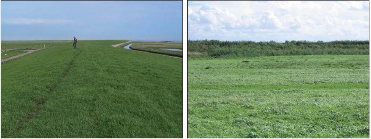
Figura 2 - Tipico aspetto di dighe costiere lungo le coste del Mare del Nord (Paesi Bassi): a) a sinistra, diga costiera da TAW (1996); b) a destra, lato terra di diga costiera a Marken (2004).
