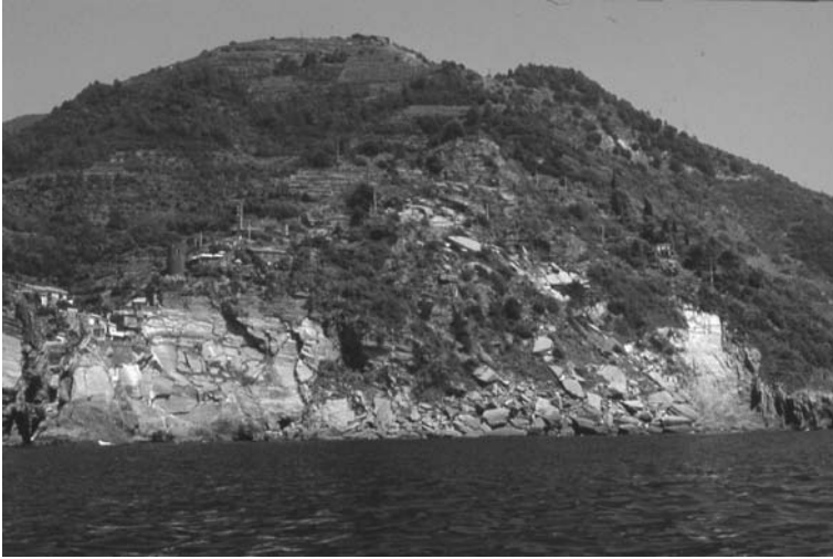
Figura 8 - Frana di Vernazza: scivolamento di blocchi svincolati da fratture ad elevata persistenza lungo i giunti di stratificazione.
