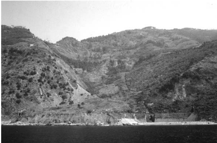
Figure 10a e 10b - Frana di Guvano: confronto fra le condizioni dell'area coinvolta dal movimento nel 1970 (foto Nosengo S.) e nel 2000.
