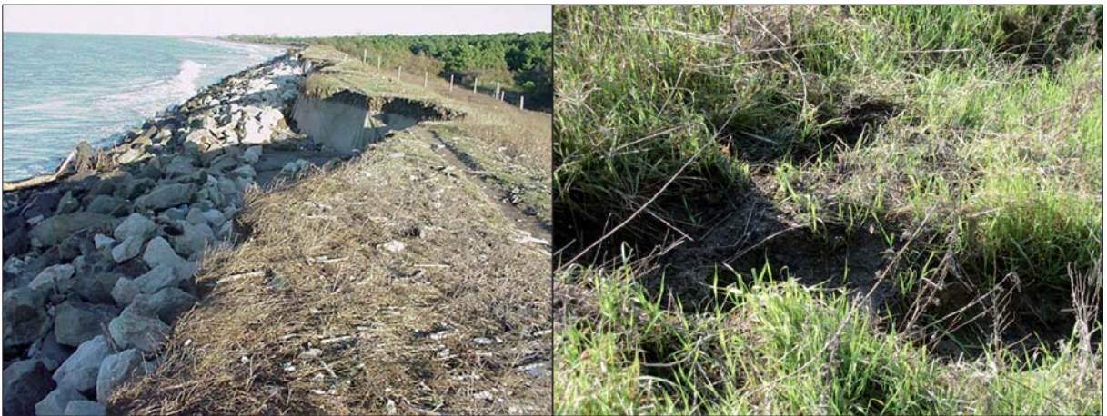
Figura 8 - Danneggiamento dell'argine scogliera di Bocche del Bianco e Pineta di Volano: a) a sinistra, lato mare (da Regione Emilia-Romagna, 1999); b) a destra, lato terra (2004).
