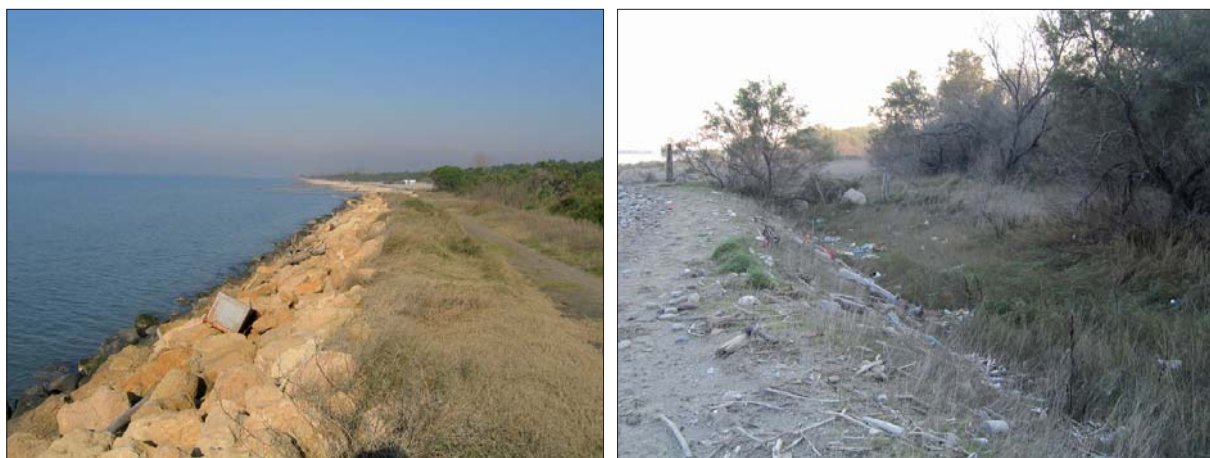
Figura 5 - Argini di difesa a mare in Italia: argine scogliera di Bocche del Bianco e Pineta di Volano (2004). a) a sinistra, lato mare; b) a destra, lato terra.
