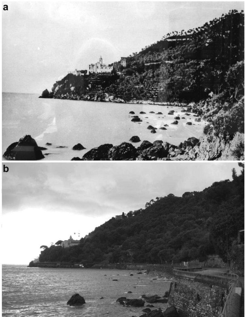
Figura 9 – Confronto fotografico storico del settore inferiore della frana delle Gave: nella foto relativa alla situazione del 1865 (a) sono ancora visibili il piede della frana emersato dall’azione di scalzamento del moto ondoso e i numerosi blocchi rocciosi emergenti nel tratto di mare antistante; nella foto relativa alla situazione attuale (b) il piede della frana è contenuto dalle opere murarie realizzate con la costruzione della strada di collegamento tra S. Margherita L. e Portofino alla fine del XIX secolo.
