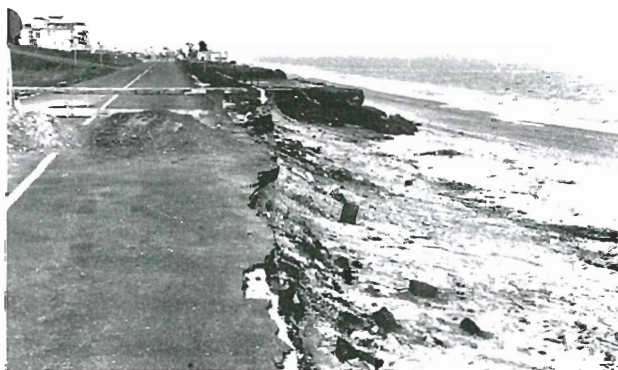
Figura 18 - Effetti dell'erosione costiera sulla spiaggia e sulla strada litoranea antistanti alla località Scossicci di Porto Recanati nel dicembre 1977.
