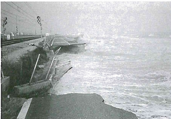
Figure 31a e 31b - Danni alle opere di recinzione ferroviaria nell'inverno all'inizio del 1997 e conseguenti provvedimenti-tampone sul sito eroso da parte dell'ente gestore della rete.
