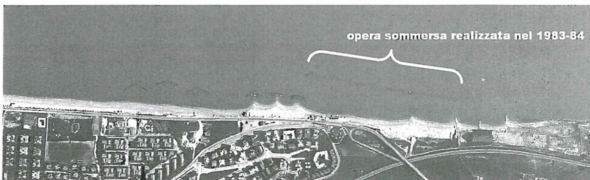
Figura 20 - Vista aerea generale del tratto costiero di Scossicci di Porto Recanati nel novembre 1985 in cui risulta visibile l'intervento di protezione con le opere sommerse.
