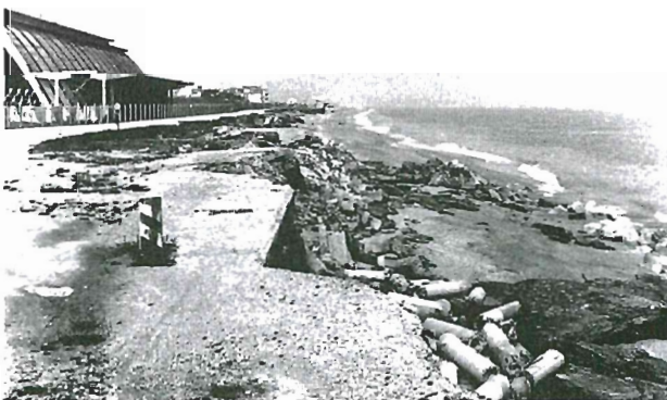
Figure 17a e 17b - Effetti dell'erosione costiera sulla spiaggia e sulla carreggiata della strada litoranea antistanti all'ex stabilimento Montecatini nel gennaio 1976.
