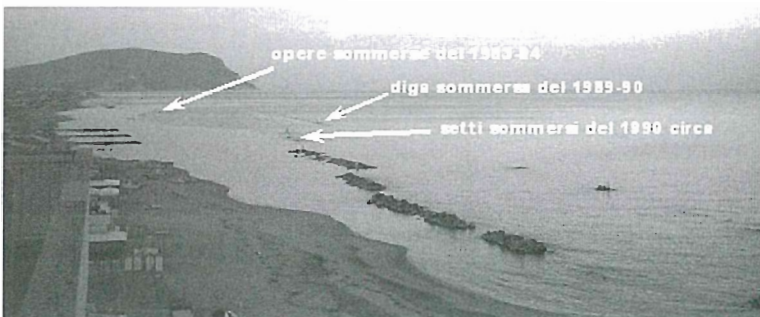
Figure 23a e 23b - Stato generale della spiaggia e delle opere di difesa della costa meridionale di Porto Recanati alla fine del 2004 in condizioni tranquille ed in occasione di una mareggiata del dicembre 2004.
