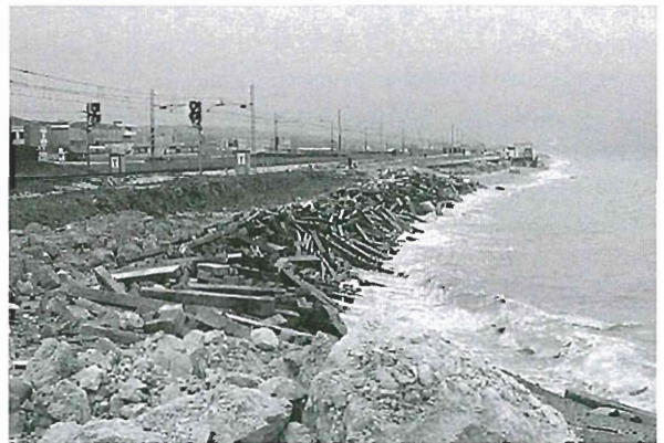
Figure 31a e 31b - Danni alle opere di recinzione ferroviaria nell'inverno all'inizio del 1997 e conseguenti provvedimenti-tampone sul sito eroso da parte dell'ente gestore della rete.
