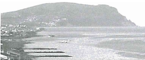
Figure 22a e 22b - La costa di Scossicci di Porto Recanati con i tre pennelli di recente realizzazione.
