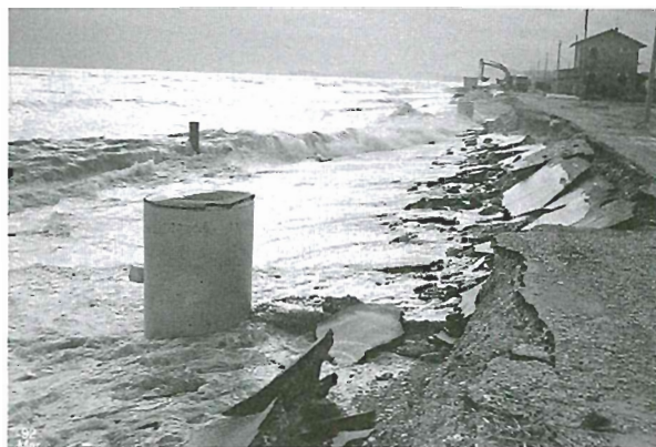
Figure 29a e 29b - Danni sottoflutto alle barriere sommerse per effetto delle mareggiate del dicembre 1991 e del marzo 1992.
