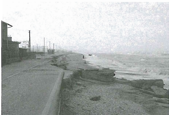
Figure 29a e 29b - Danni sottoflutto alle barriere sommerse per effetto delle mareggiate del dicembre 1991 e del marzo 1992.
