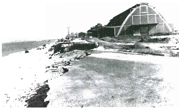
Figure 17a e 17b - Effetti dell'erosione costiera sulla spiaggia e sulla carreggiata della strada litoranea antistanti all'ex stabilimento Montecatini nel gennaio 1976.
