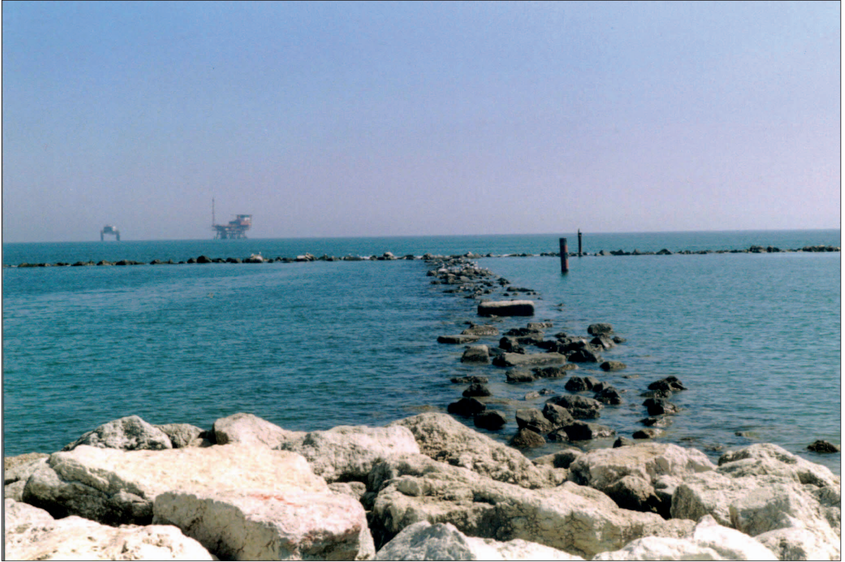
Figura 42 - Lido di Dante: setto trasversale di collegamento tra la scogliera semisommersa longitudinale e il pennello di ancoraggio alla spiaggia.
