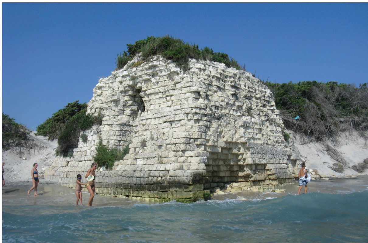
Figura 5 – Torre Fiumicelli conserva oggi solo il piano terra che ospita una cisterna voltata a botte. La torre si presenta ubicata in corrispondenza della battigia e con il piede sommerso dai sedimenti di spiaggia. Il moto ondoso ha raggiunto solo da qualche anno lo spigolo NE della torre a causa degli intensi fenomeni erosivi che stanno interessando il litorale. Una profonda nicchia erosiva minaccia oggi la stabilità della torre.
