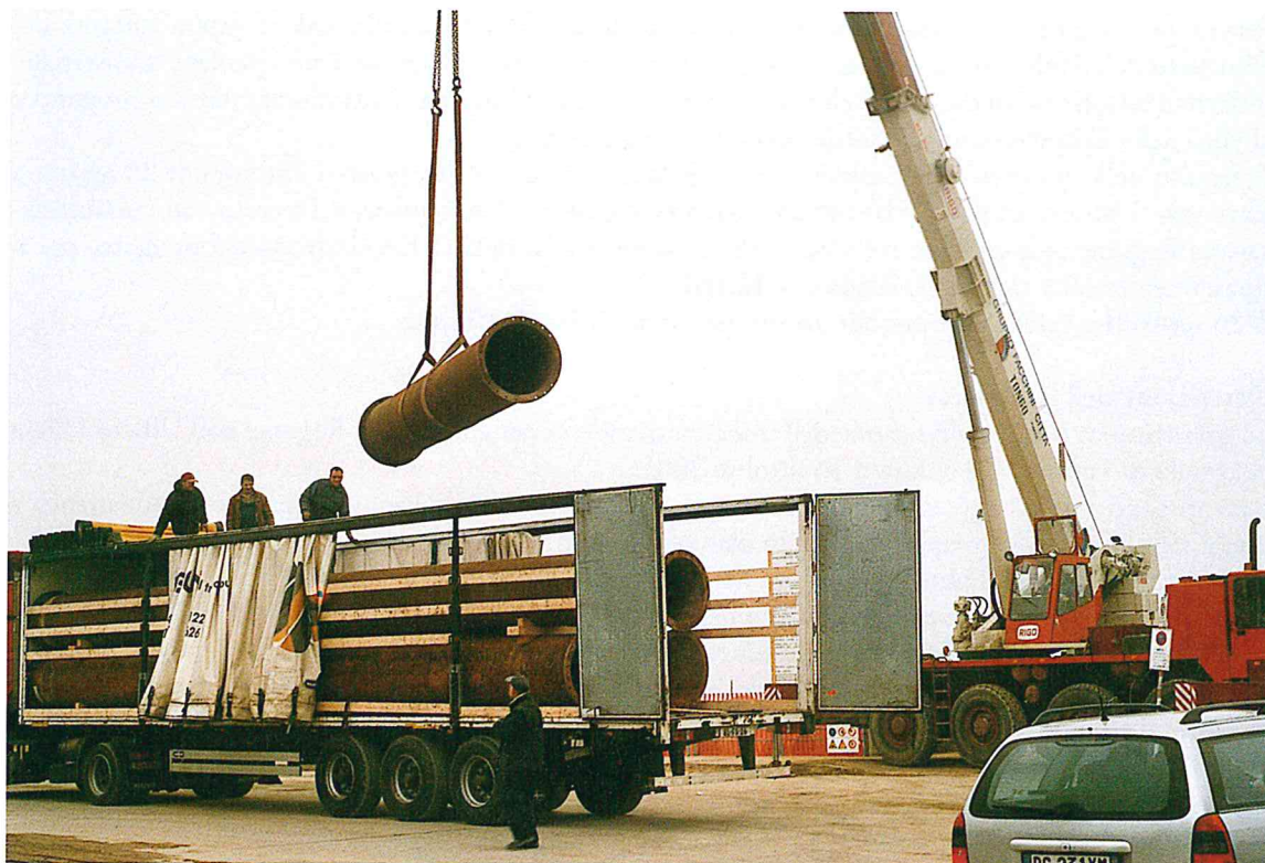
Figura 7 - Riccione: operazione di scarico dei tubi trasportati via terra dal nord Europa.
