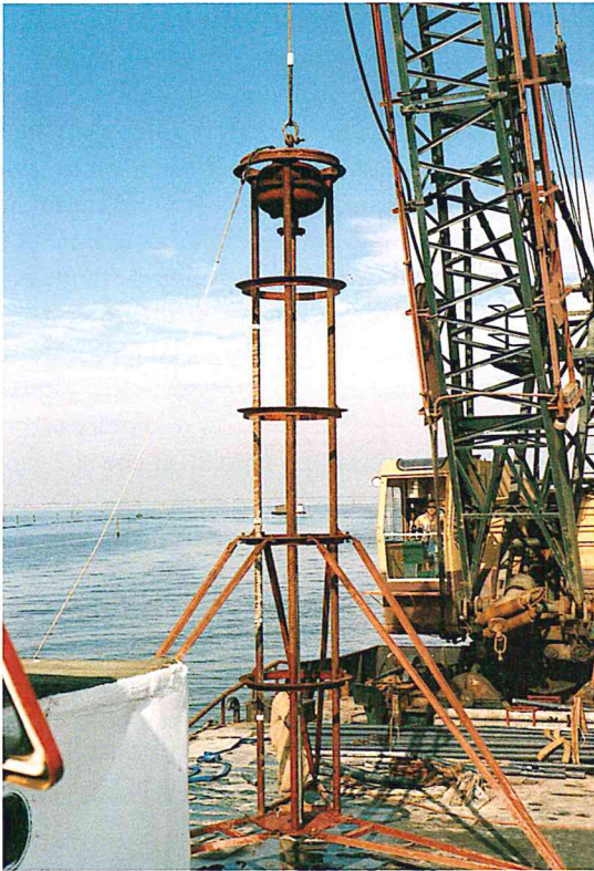
Figura 4 - Il carotiere utilizzato per la campagna geognostica 2000 in posizione verticale sul pontone.
