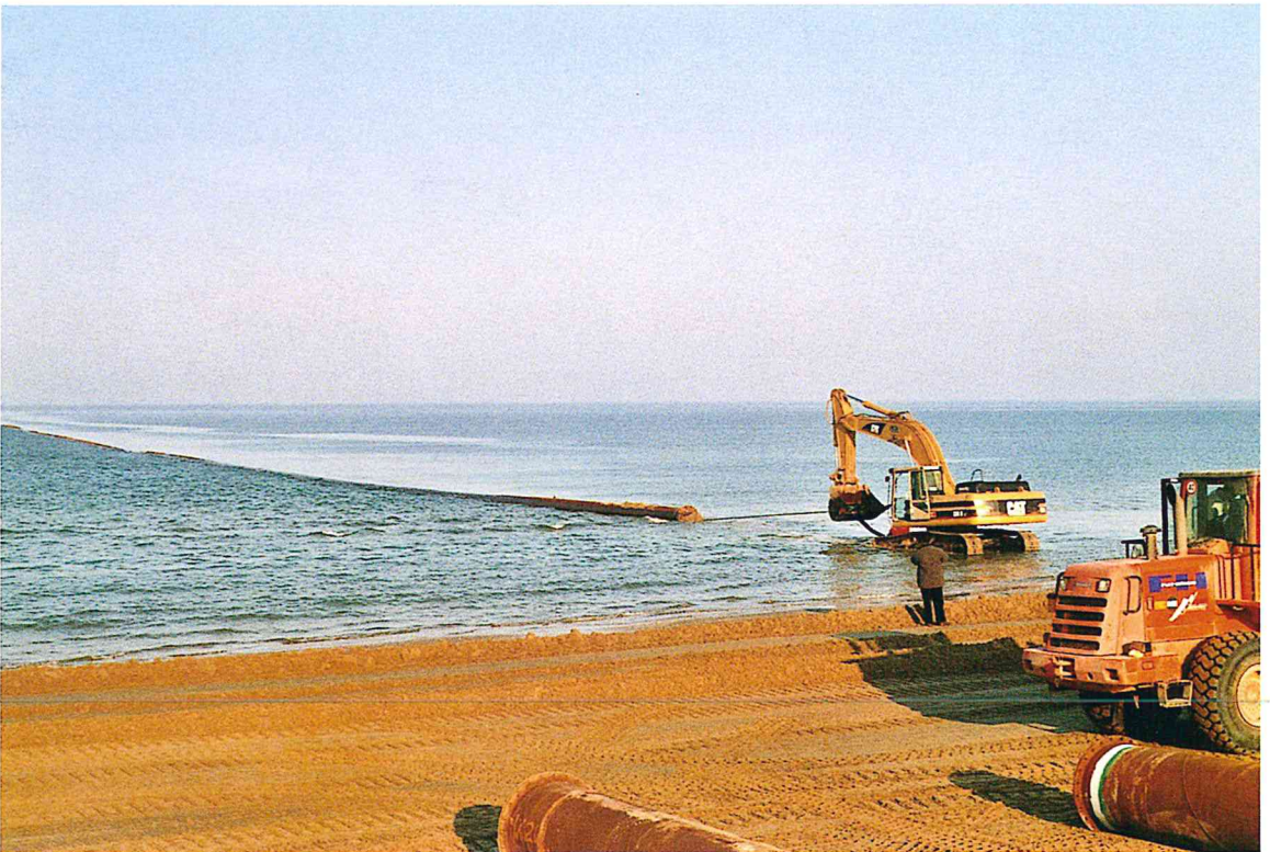
Figura 10 - In alto: tubazione in galleggiamento manovrata da un mezzo navale durante la fase di avvicinamento alla spiaggia; in basso: la stessa tubazione viene agganciata da una pala meccanica per essere tirata sulla spiaggia.
