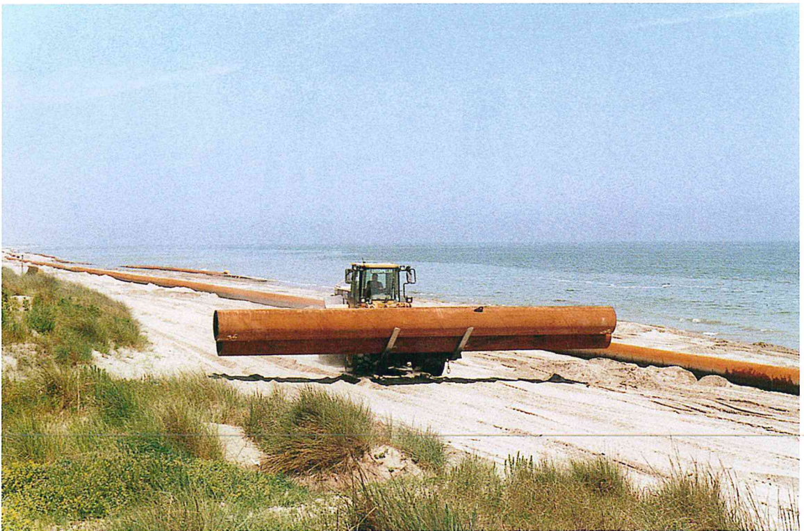
Figura 13 - Operazioni di recupero e risezionatura delle tubazioni a fine lavori.
