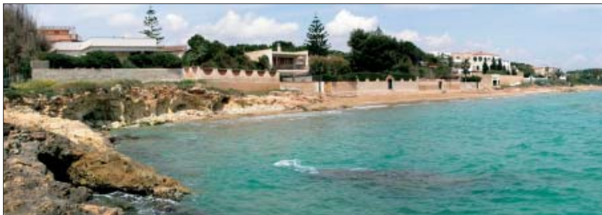
Problemi di erosione accelerata a Marina di Noto (Provincia di Siracusa).
