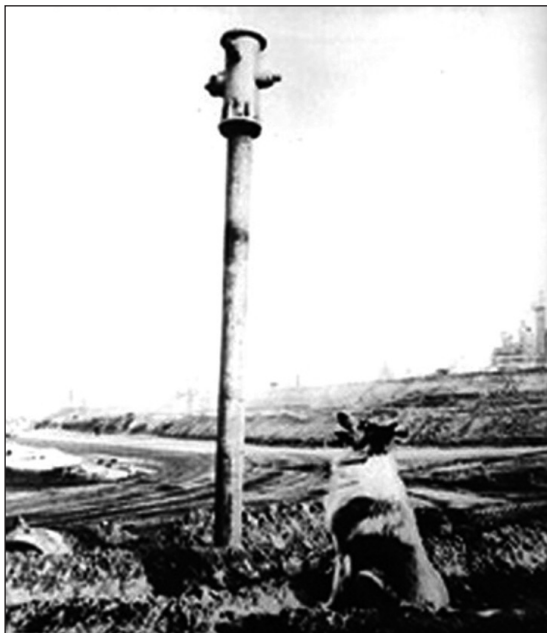
Figura 4 - Effetto della subsidenza su di un idrante nel porto di Long Beach (Foto tratta da http://www.uwsp.edu/geo/faculty/ozsvath/images/long_beach_subsidence.htm ).
