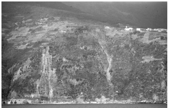
Figura 13 - Vista frontale del versante retrostante lo "Spiaggione" di Corniglia e dei fenomeni d'instabilità che lo interessano.
