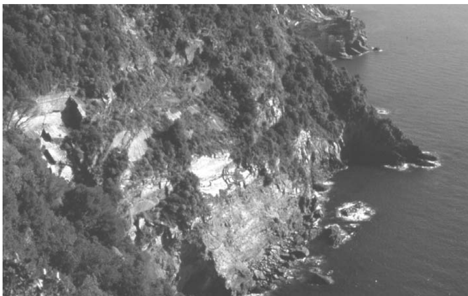
Figura 5 - Fenomeni di crollo nel tratto compreso fra Scoglio del Frate e Valle Crovarla. Alla base della falesia sono visibili alcune grotte di interstrato.
