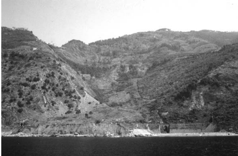
Figure 10a e 10b - Frana di Guvano: confronto fra le condizioni dell'area coinvolta dal movimento nel 1970 (foto Nosengo S.) e nel 2000.
