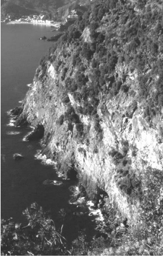
Figura 6 - Scivolamenti traslazionali fra Valle Crovarla e Punta Linà in corrispondenza della zona di cerniera di una piega con asse circa parallelo alla linea di costa (direzione NNO - SSE).
