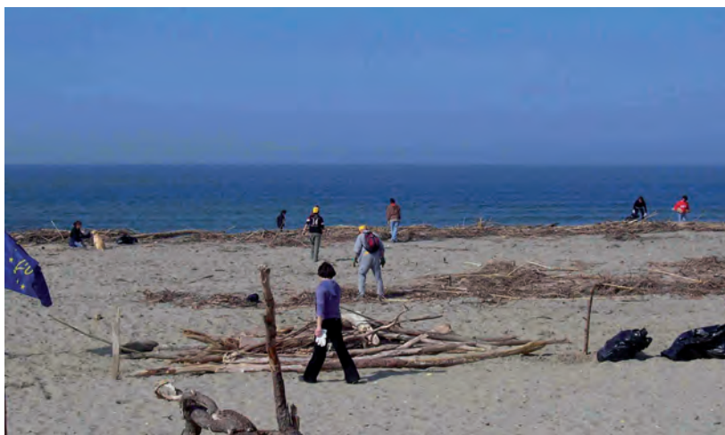
Figura 15 - Costruzione di "fascinate artigianali" da parte di volontari per innescare lo sviluppo di dune incipienti in luogo dell'utilizzo di mezzi meccanici per la "pulizia" che eliminano le dinamiche naturali di evoluzione dunare.
