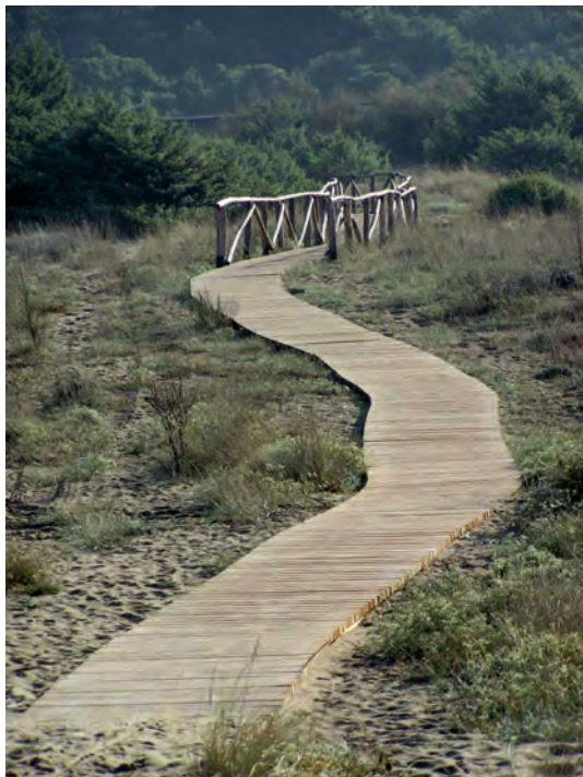
Figura 11 - Sentiero a terra per indirizzare e concentrare il calpestio in area dunare (Foto Andrea Porchera).
