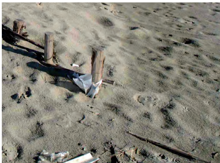
Figura 9 - Intervento di ricostituzione della duna in un'area intensamente frequentata (a sinistra). Le viminate impediscono il passaggio e innescano l'accumulo di sabbia come farebbero i tronchi spiaggiati. La stessa zona dopo pochi mesi (a destra).
