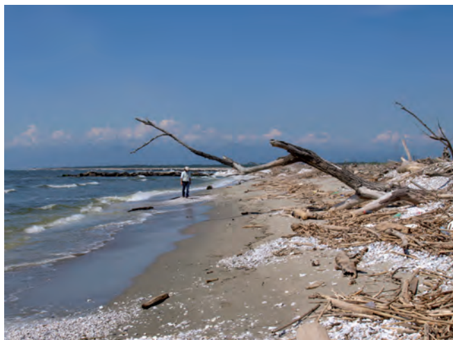
Figura 3 - Pennelli emersi, prolungati a mare come setti sommersi, e ripascimento in ghiaia per la difesa della spiaggia de Le Lame.
