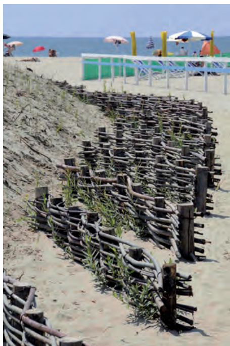
Figura 9 - Intervento di ricostituzione della duna in un'area intensamente frequentata (a sinistra). Le viminate impediscono il passaggio e innescano l'accumulo di sabbia come farebbero i tronchi spiaggiati. La stessa zona dopo pochi mesi (a destra).
