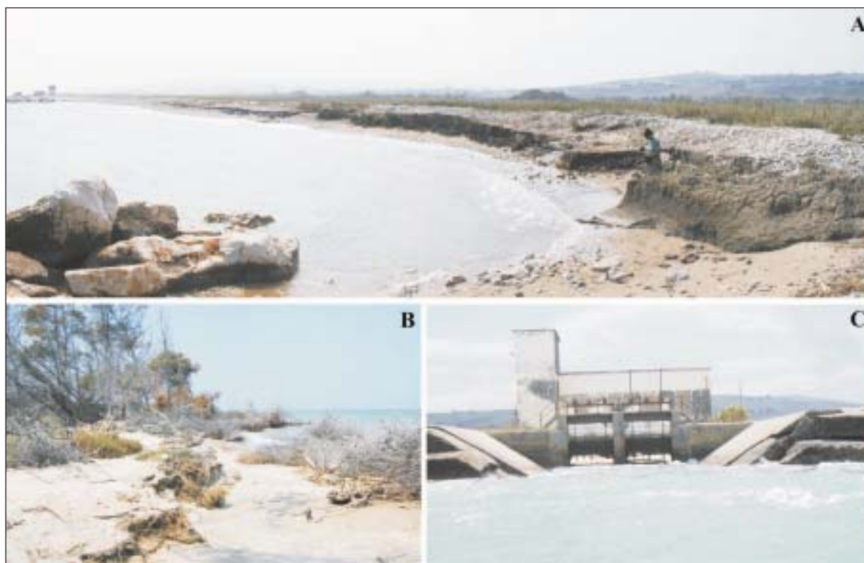
Fenomeni di arretramento della linea di riva in atto in destra della foce del Trigno lungo la spiaggia di Marinelle rispettivamente a nord (a) e a sud (b) dell'idrovora di Montenero di Bisaccia (c), attualmente interessato da evidenti fenomeni di scalzamento.
