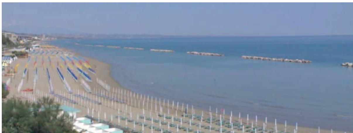
Figura 1. Tomboli a tergo di un sistema di barriere parallele emerse ed utilizzo intensivo dell'arenile.
